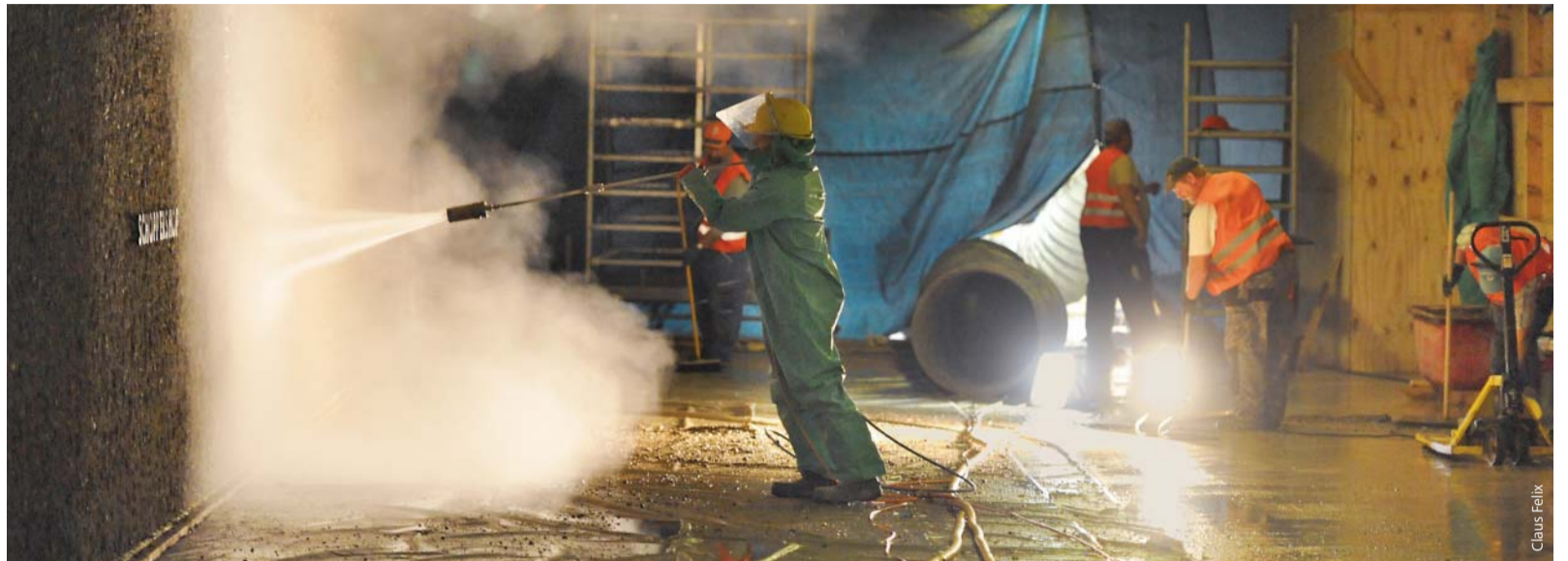
Auch Betonwände müssen saniert werden: Mit dem Höchstdruckwasserstrahler werden Kalk und lose Teile am U-Bahnhof Schoppershof entfernt.
