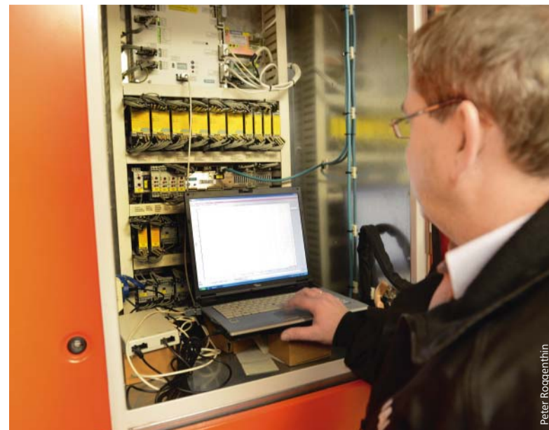
Thomas Trebes prüft den Energiespeicher am Unterwerk Fürth Hardhöhe.
