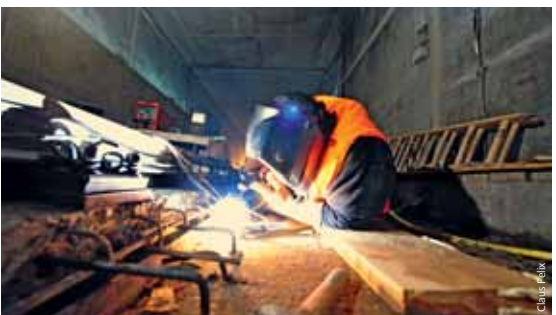
Schweißarbeiten: Betonlängsbalken und Bodenplatte werden verbunden.
