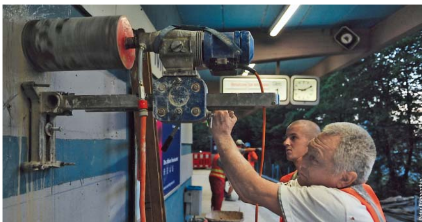
Spätabends: Eine neue Tür zu einem Betriebsraum an der Messe wird in die Betonwand gebohrt.
