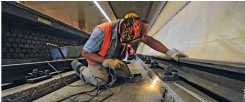
Die VAG investiert regelmäßig ins Netz, um den Bestand zu erhalten. Hier werden Betonlängsbalken saniert.
