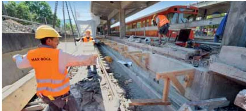
U1-Baustelle Scharfreiterrung: Diese Betonplatte wird präzise als Teil der neuen Bahnsteigkante eingesetzt.
