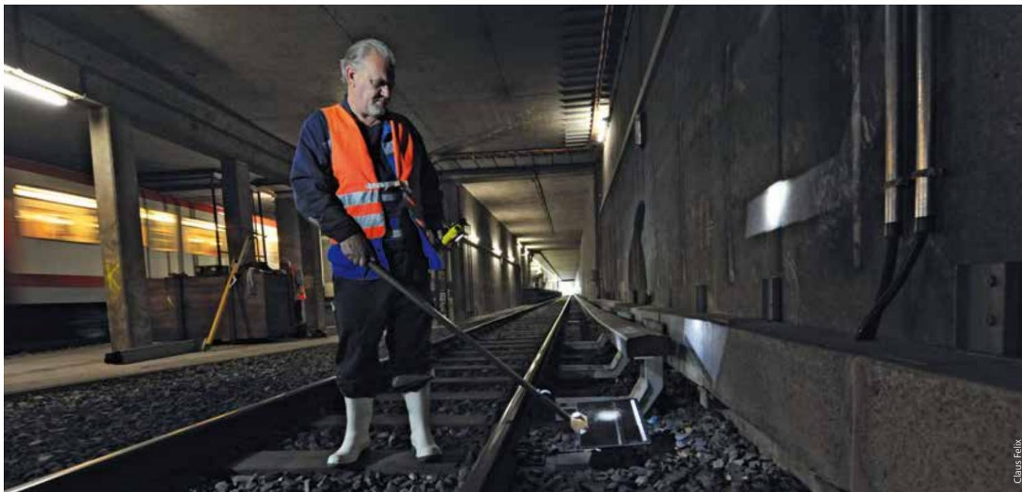
Sorgfältig überprüft Gerhard Bauer mit einem Spiegel die Stromschiene der U-Bahn und inspiziert das Laufbild, um mögliche Schäden festzustellen.
