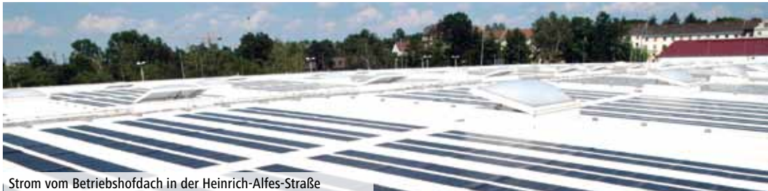
Strom vom Betriebsfordach in der Heinrich-Alfes-Straße
