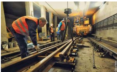
Mit schwerem Gerät werden die alten Schienenstücke gegen neue getauscht.
