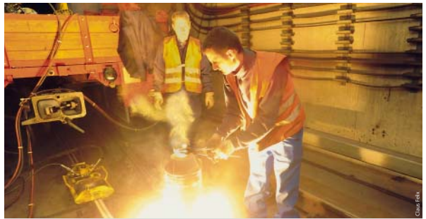
Gleißendes Licht erhellt den Tunnel, wenn flüssiges Eisen zwischen die einzelnen Schienenstücke läuft.
