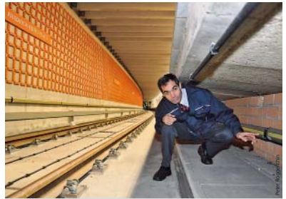
Der Raum unter der Bahnsteigkante bietet Schutz vor einfahrenden Zügen.
