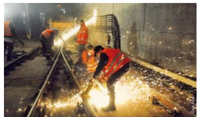
Wenn die alten Schienen in Stücke geschnitten werden, fliegen die Funken.
