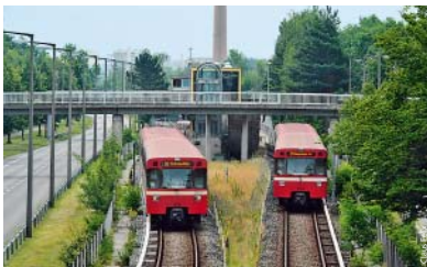
Der Stadtratsbeschluss zum U-Bahn-Bau machte Langwasser attraktiv.
