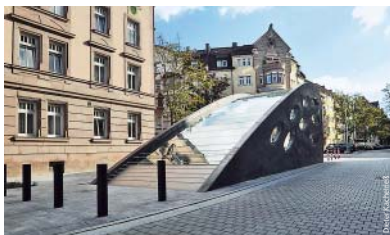
Der Zugang U-Bahnhof Kaulbachplatz spiegelt seine Umgebung wider.
