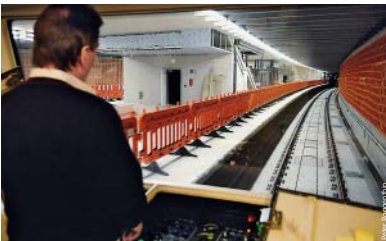
Erste Prüffahrt: Der U-Bahn-Zug fährt in den Bahnhof Friedrich-Ebert-Platz.
