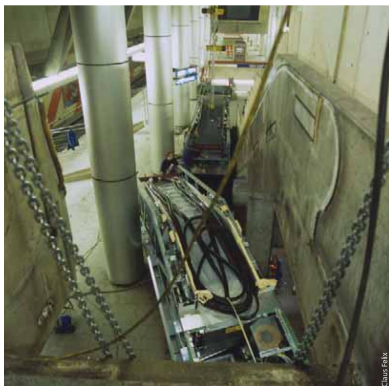
Mit Winden und Flaschenzügen erfolgt der Einbau der neuen Rolltreppe.
