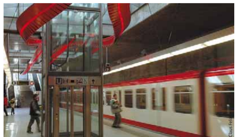
Ein Plus für Mobilitätsbehinderte: Aufzüge in allen U-Bahn-Stationen.
