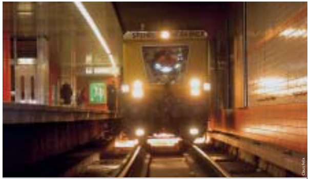
Ein außergewöhnlicher Anblick im U-Bahn-Netz: Im Februar und März schleift der Spenzog die Schienen.
