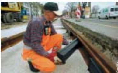
Baustoffe, wie Kammerfüllsteine für Schienen, stammen aus der Region.
