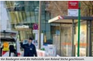
Vor Baubeginn wird die Haltestelle von Roland Sticha geschlossen.
