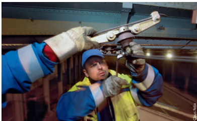
Reparaturen an Oberleitungen sind Präzisionsarbeit unter Hochdruck.
