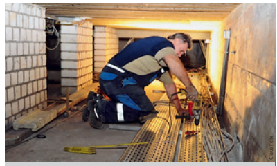
Bis Mitte September wird die Stromversorgung in Langwasser Süd erneuert.
