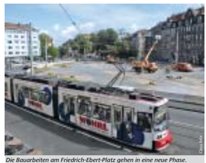
Die Bauarbeiten am Friedrich-Ebert-Platz gehen in eine neue Phase.
