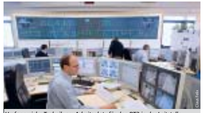
Umfangreiche Technik am Arbeitsplatz für den DT3 in der Leitstelle.
