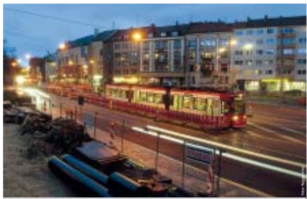
Größtbaustelle Friedrich-Ebert-Platz: Hier entsteht ein U-Bahnhof. Die Straßenbahngleise werden verschoben.
