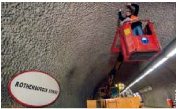
Auch den Beton der Tunneldecke nehmen die Prüfer genau unter die Lupe zur Sicherheit der Fahrgäste.
