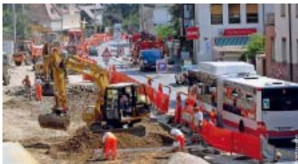
Großbaustelle Erlenstegenstraße. Bis zum Fahrplanwechsel im Dezember ersetzen Busse die Straßenbahnlinie 8.
