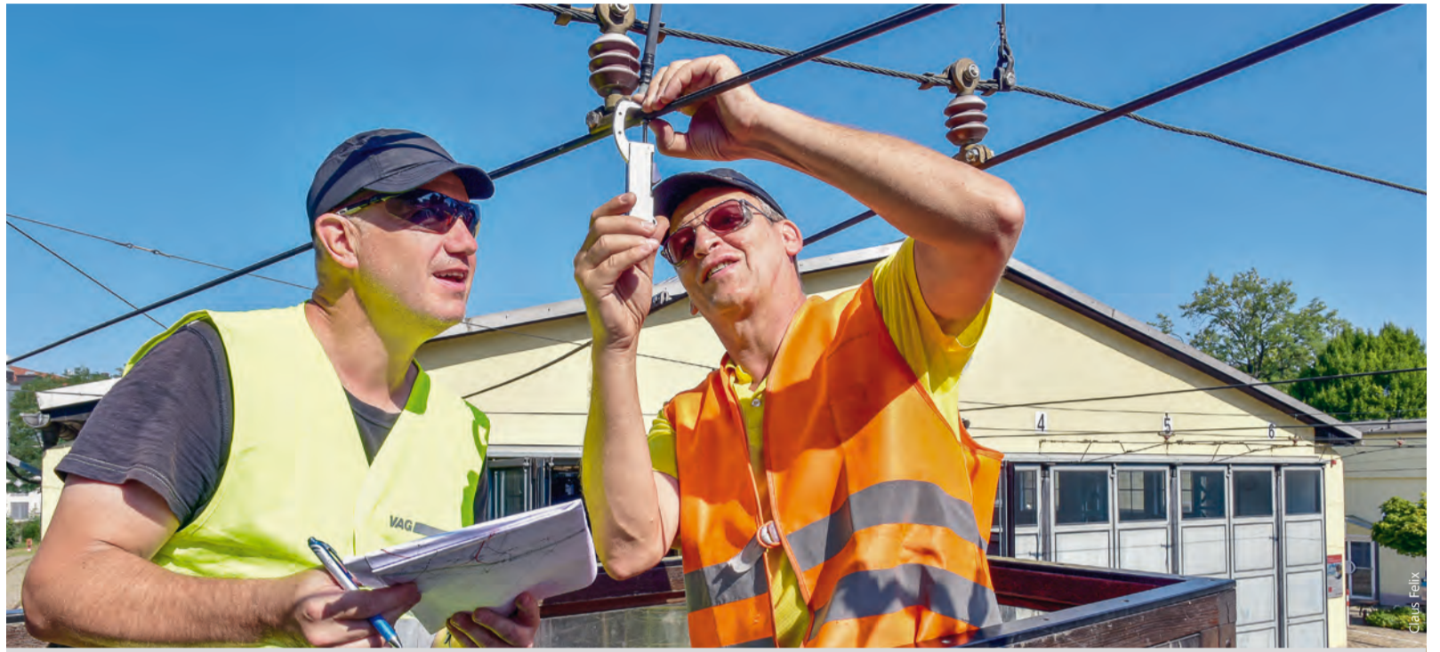
Für Jens Haban (l.) und Roland Weber ist das Prüfen des Fahrdrahtes spannungsgeladene Routine, die dennoch volle Konzentration erfordert.
