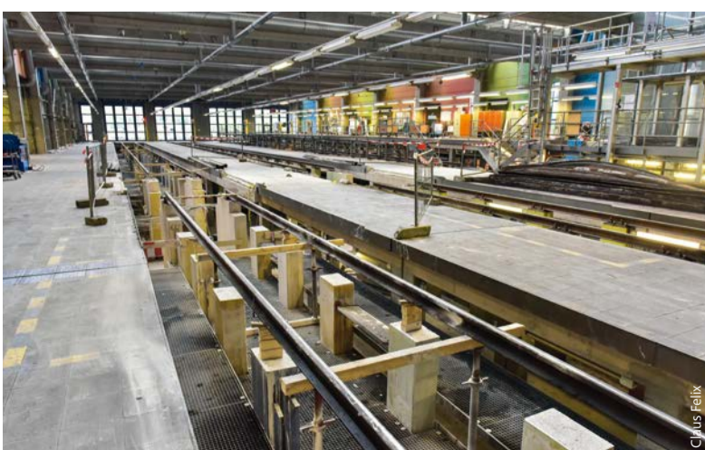
Dieses lange Gleis ist dem neuen G1-Zug in der Werkstatt vorbehalten.
