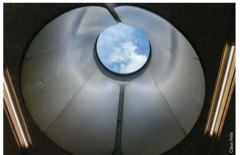
Die Lichtkuppeln bringen Tageslicht in unterirdische U-Bahn-Stationen.
